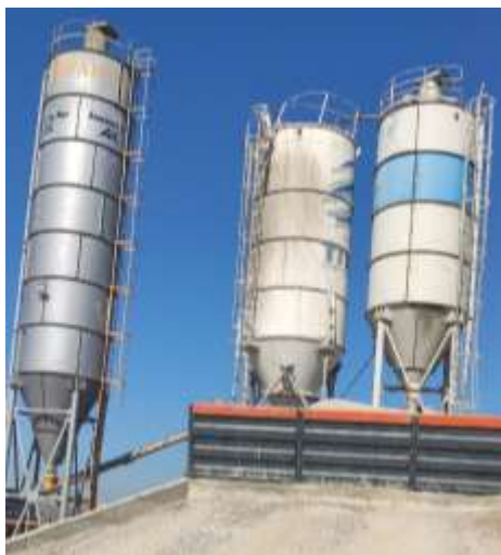
Слика 4 Силоси за цемент
